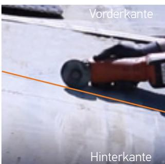
11| Zurück an der Hinterkante, schneiden Sie das Band entsprechend der Linie bis zum Schnittpunkt ab.
