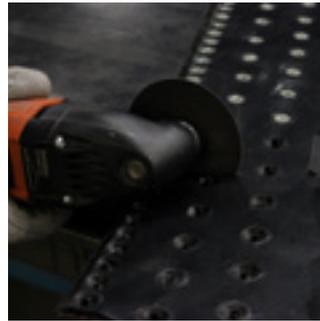
27| Falls nötig, schneiden Sie den **SUPER-SCREW®** entlang der Kanten des Bandes ab.
